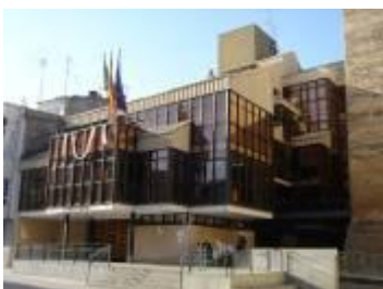
Edificio 1: Ayuntamiento Benifaio
