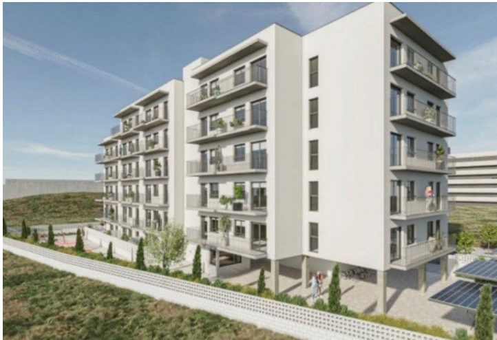
Edificio 50 viviendas de protección pública y 6.225 m 2 en Humanes (Plan Vive)
