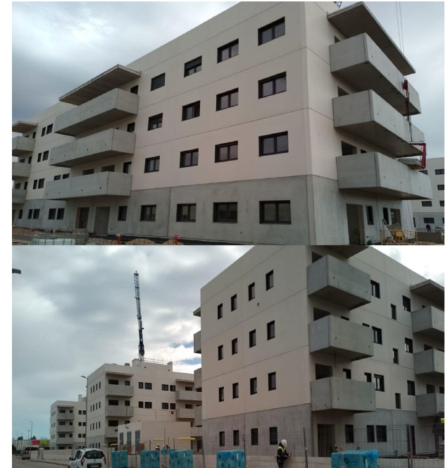
4 Edificios con 124 viviendas en Cubeles (9.965m 2 ) Promotor fundació Nou Lloc - SALAS Plus Habit/ Constructor y Arquitectos SALAS Constru Habit
