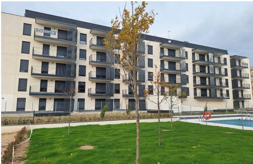
4 edificios con 354 viviendas en Tres Cantos
