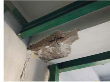
Foto 39: Oxidación de acero en viga de techo de planta baja.
