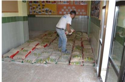
Foto 25: Proceso de carga en forjado para la realización de PRUEBA DE CARGA
