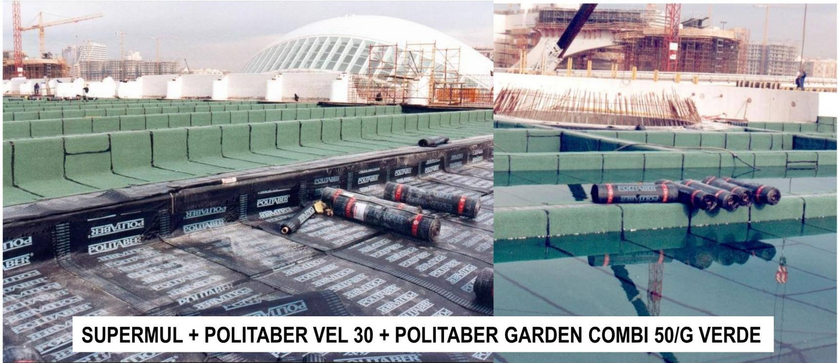
*Membrana bicapa adherida anti-raíz. Membrana bituminosa con POLITABER GARDEN. Cubierta ajardinada de L'Umbracle. Ciudad de las Artes y las Ciencias. València. Fuente: ChovA. Año 2000*
