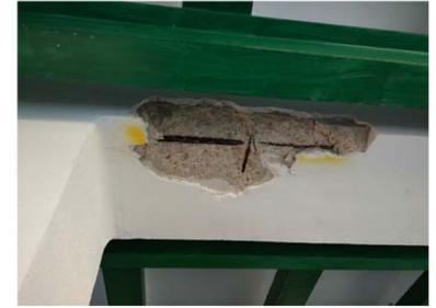
Foto 40: Oxidación de acero en viga de techo de planta baja.
