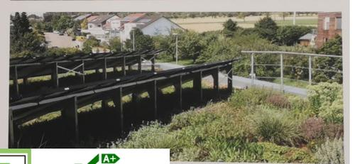
Ejemplo de integración de fotovoltaica en cubierta verde.
