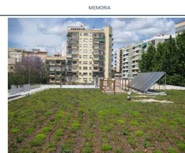
Figura 44. Cubierta vegetada en la azotea del colegio Gonzales Vera en el municipio de Xàtiva (Valencia). Proyecto AQUAVAL.
