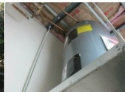
Figura 45: Elevar caldera apoyándola sobre plataforma (Waggoner & Ball)
