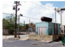
Figura 49: Barrera exterior protegiendo generador eléctrico (FEMA)
