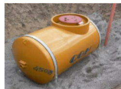
Figura 52: Tanque sobre suelo anclado con correas (cghnordic)
