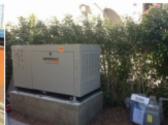
Figura 44: Elevar equipo instalado en el suelo sobre plinto (assurancepower)
