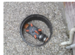
Figura 64: Válvula antirretorno (Aquobex)
