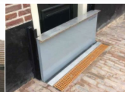
Figura 20: Compuerta con autocierre por empuje de crecida (Aggèrès)
