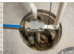
Figura 33: Bomba de achique en sumidero (123RF)
