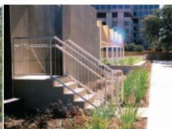
Figura 41: Acceso elevado a zona habitable (FEMA)
