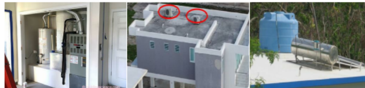
Figura 46: Reubicación de equipos en armario de instalaciones de planta superior (buildingscience.com)
