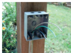
Figura 56: Conductores para uso con riesgo de ser mojados (FEMA)
