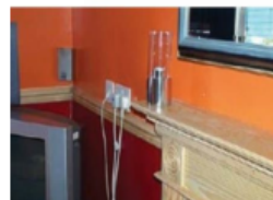
Figura 43: Elevar instalación eléctrica y equipos (Homeowners guide to flood resilience)
