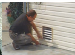
Figura 32: Compuertas de drenaje (FEMA)
