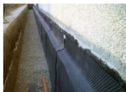
Figura 31: Sistema de drenaje de muro (ferreteriicornellana.com)
