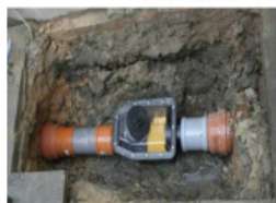
Figura 25: Válvula antirretorno (Aggères)
