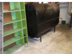
Figura 53: Tanque sobre suelo con apoyos embudidos en losa de hormigón (FEMA)
