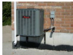
Figura 58: Elevación de equipos (Ardentcanada)
