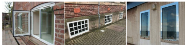
Figura 22: Ventana resistente a las inundaciones. Abatible (Mengineering)
