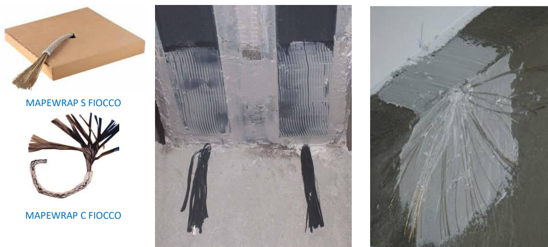
Figura 24: Colocación de los Fioccos
