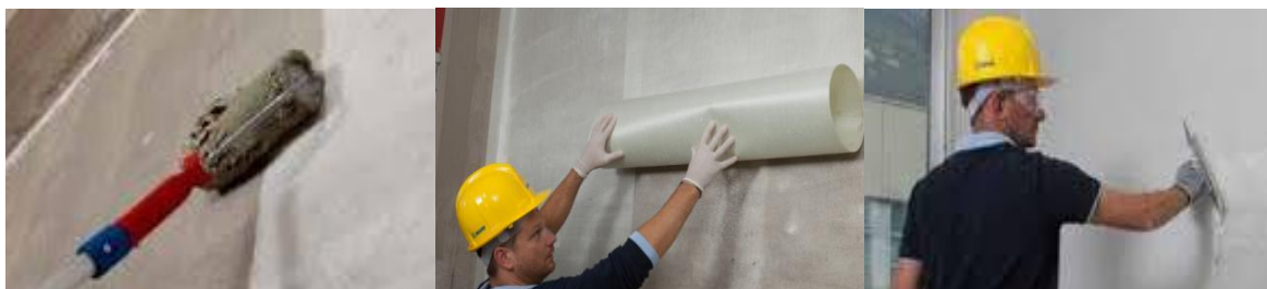
Figura 35: Colocación del tejido
