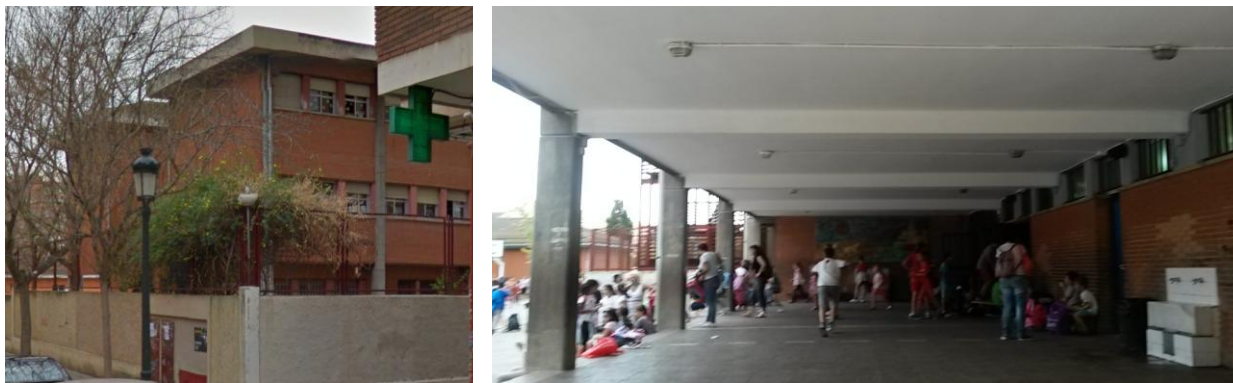
Figura 15: Factores de riesgo debidos a la estructura y composición de fachada
