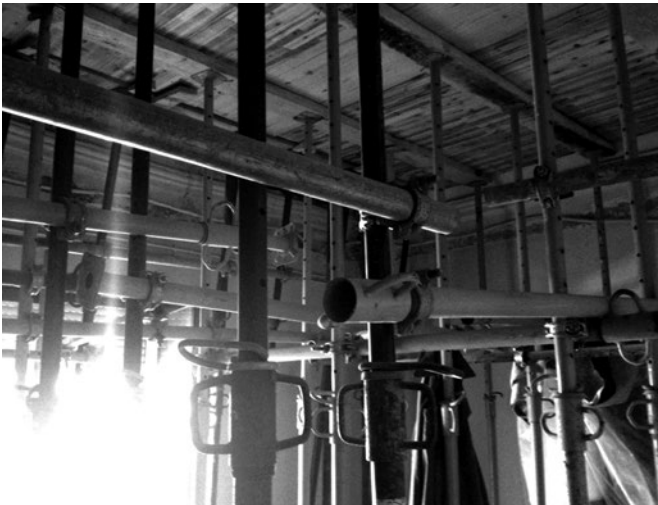
Figura 6. Arriostramiento poco ortodoxo que demuestra que hay abrazaderas.
